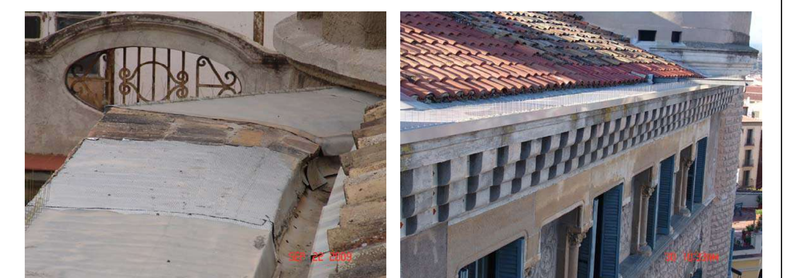
FOTOGRAFIES ESTAT ACTUAL CANALERA COBERTA
