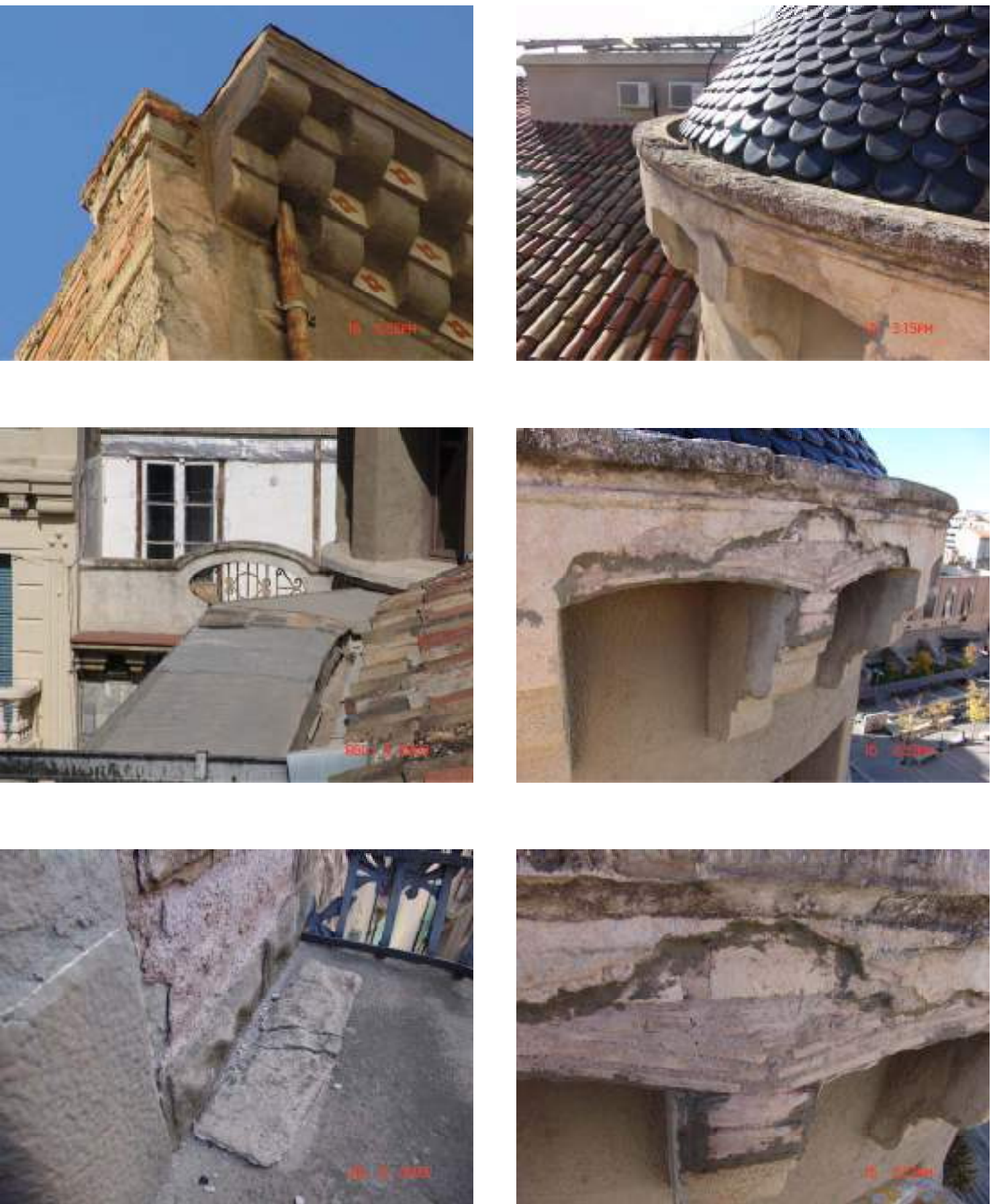
FOTOGRAFIES ESTAT COBERTA
