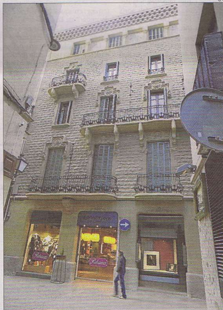
La part que es va restaurar el 2015 des del carrer de la Canal, ahir
